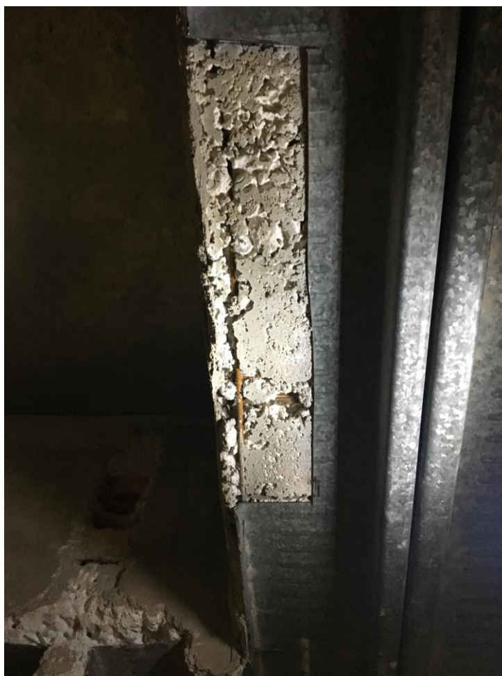
Figura 6. Canto de losa de 11 cm y armadura de malla de 15x15 con redondos de 5 y 5. Acero B 400 S.
