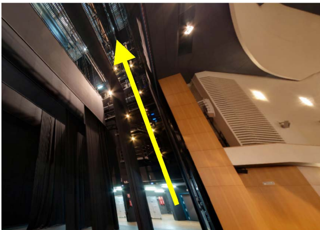
Figura 1. Indicación del lugar donde se realizó la inspección en la caja escénica de la sala Narciso Yepes,
