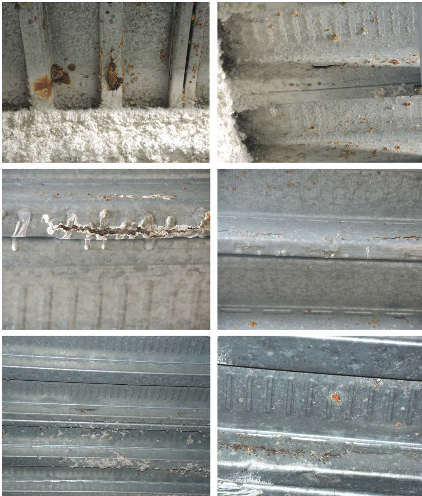
Figura 2. Imágenes de distintas localizaciones de la chapa del forjado colaborante situada en la zona de la caja escénica
