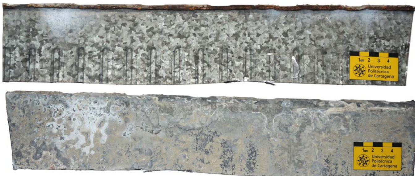
Figura 5. Muestra de chapa en buen estado. Cara visible y cara en contacto con el hormigón, respectivamente
